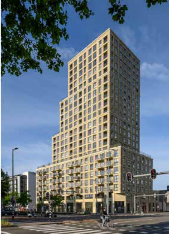
Woongebouw met plint, podium, toren en setbacks
