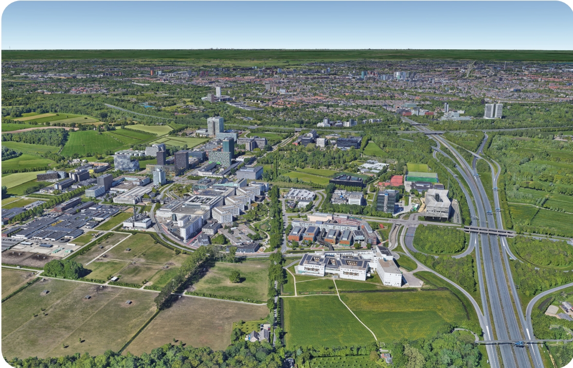
Het campuspark ligt op een strategische plek binnen de Utrecht Science Park-campus, tussen de Hoofddijk en het omliggende landschap. Het vormt een schakel tussen de verschillende zorg- en onderzoeksgebouwen en heeft de potentie om uit te groeien tot een samenhangend en herkenbaar centraal gebied.
