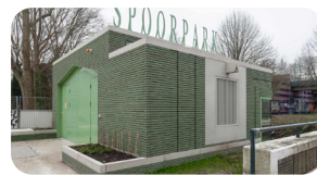
Roosters, technische voorzieningen en onderhoudstoegangen worden zorgvuldig mee-ontworpen in materiaal, kleur, positie en detaillering, zodat zij onderdeel zijn van de architectuur.
