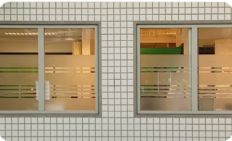
Bestaande gevelmaterialisering met witte tegels
