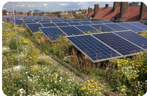
Kruidendak i.c.m. PV-panelen
