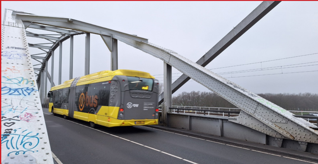
De bestaande Jutfasebrug over het Amsterdam Rijnkanaal
