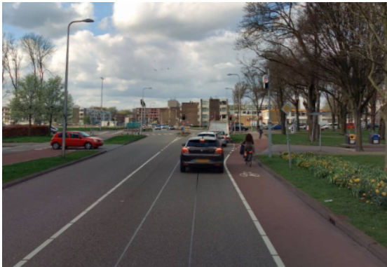
Humberdreef – doorgetrokken fietsstrook op 2 richtingen rijbaan met as-markering
