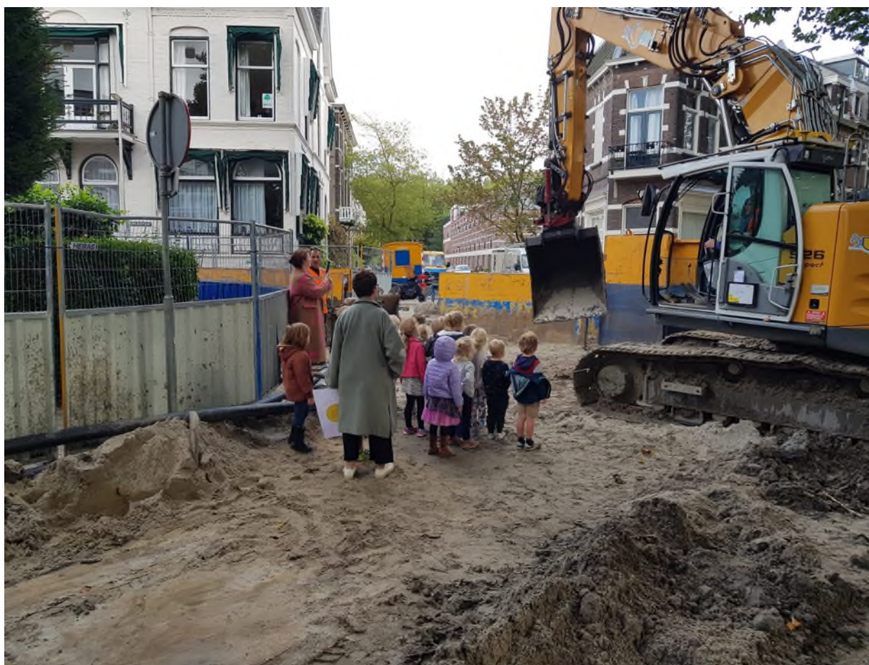
Aanleg hemelwaterriool Zeeheldenbuurt
