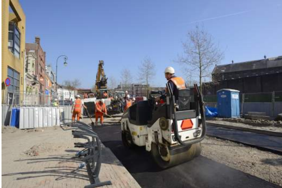
Afbeelding 2: Aanleg asfalt
