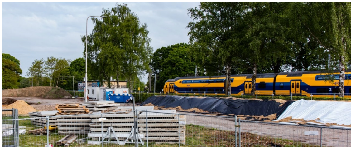
Afbeelding 13: Bouwplaats naast de spoorrails. Een trillingsgevoelige locatie
