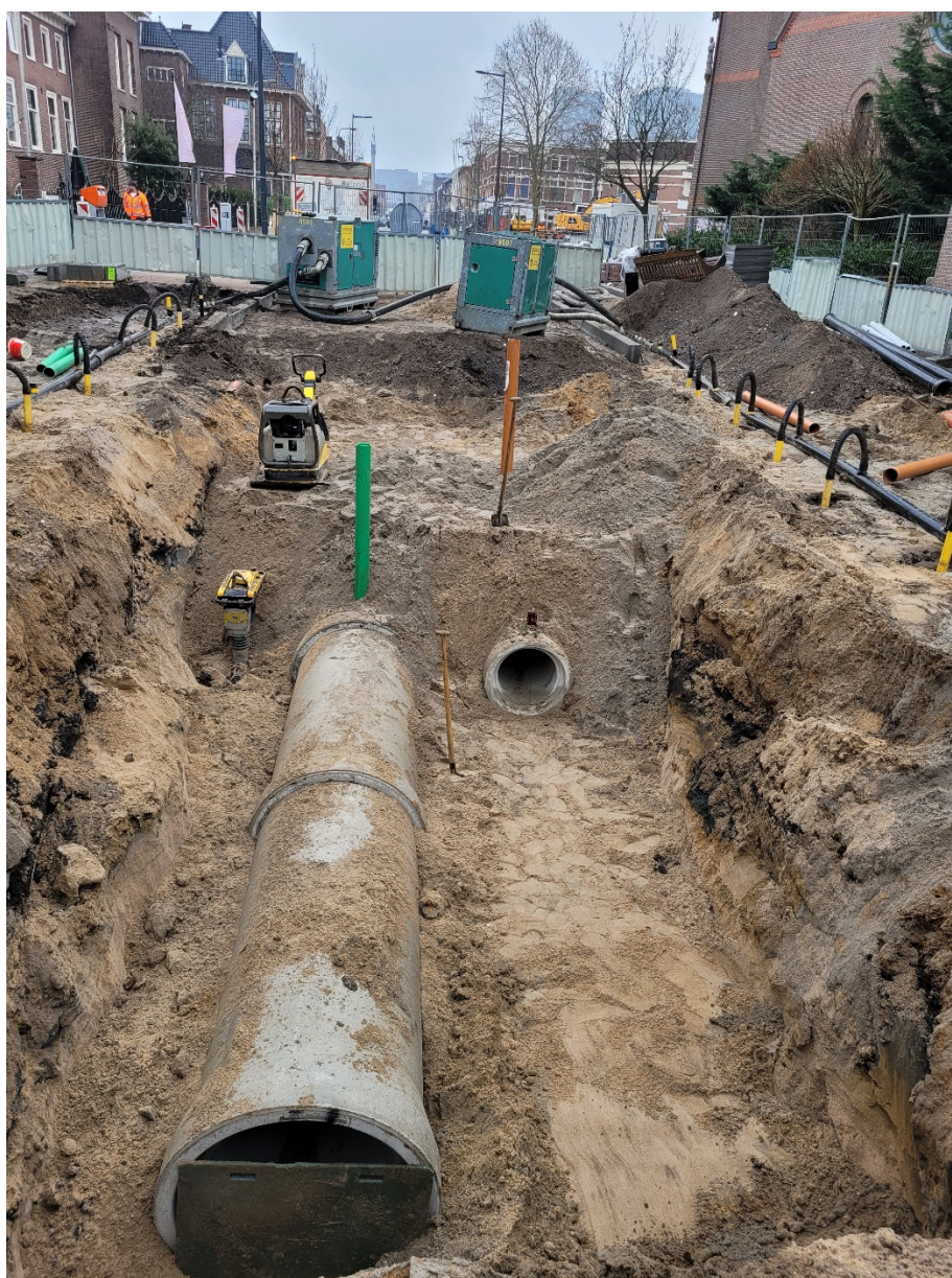
Aanleg gescheiden riolering Kanaalstraat
