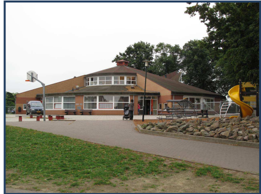
Kapconstructie, puntdaken, leien + pannen
