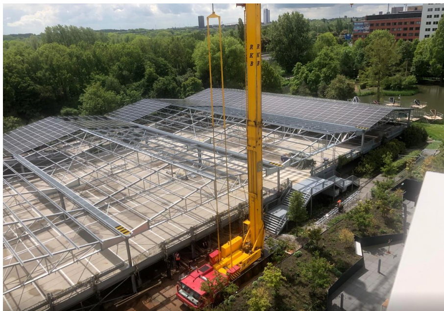
Figuur 14 - Solar carport in aanbouw bij hoofdkantoor a.s.r. Utrecht
