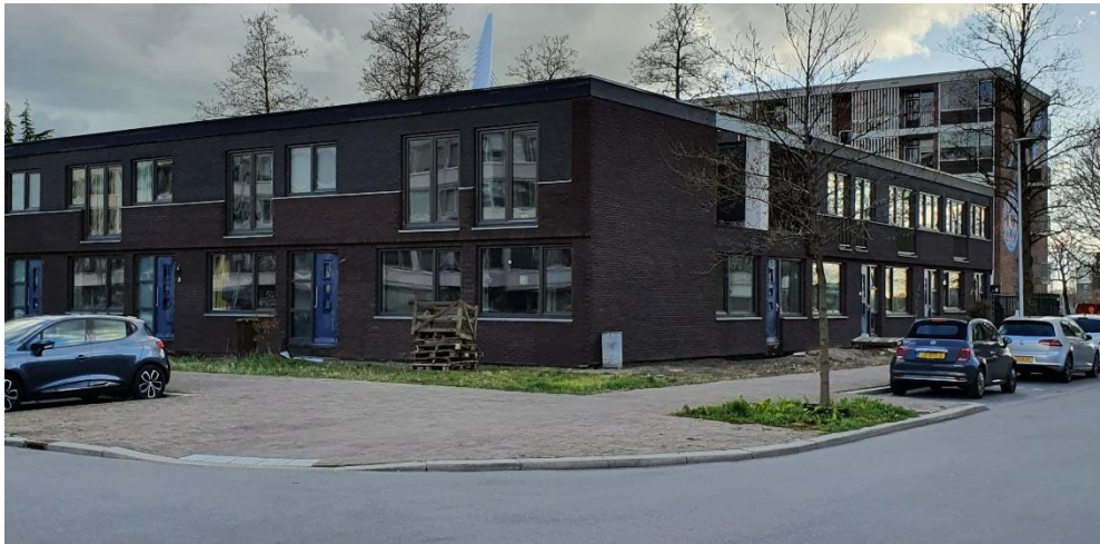
Figuur 1.1 Huidige situatie (11 april 2021) Kluswoningen Kanaleneiland
