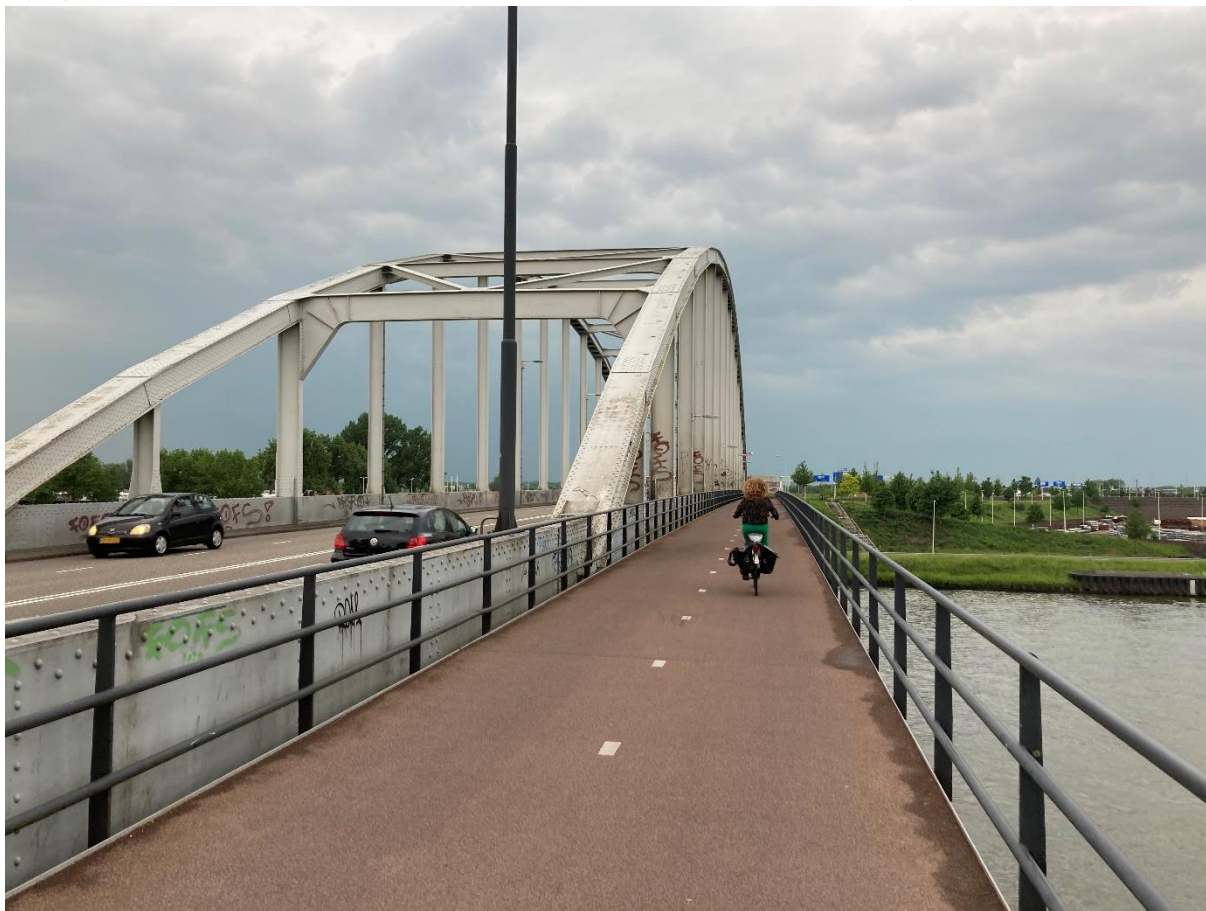
Bijlage 3 Foto van het bestaande 4m brede fietspad aan De Meernbrug
