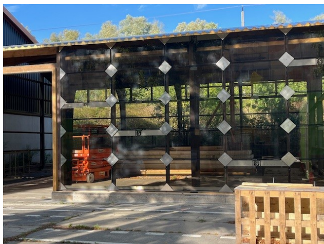
De wand van NS-ramen van het Upcyclecentrum in aanbouw
