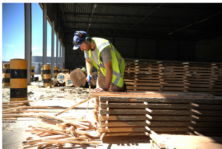
Zagen en oplatten van stammen in het Grondstoffendepot
