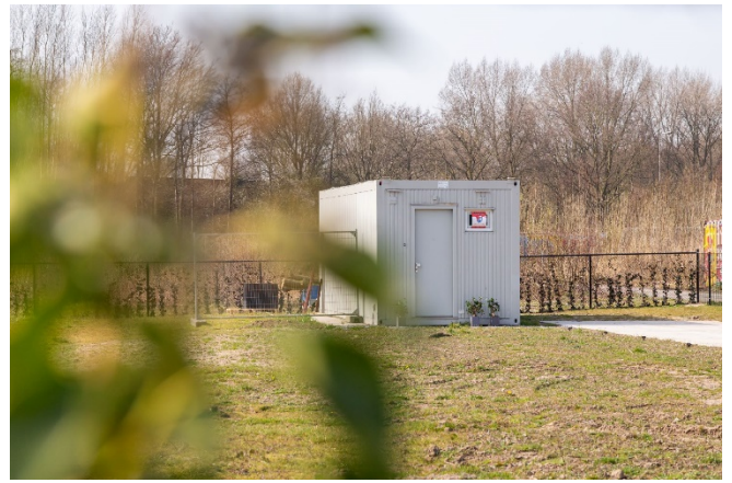
Eén van de 2 bestaande cabins
