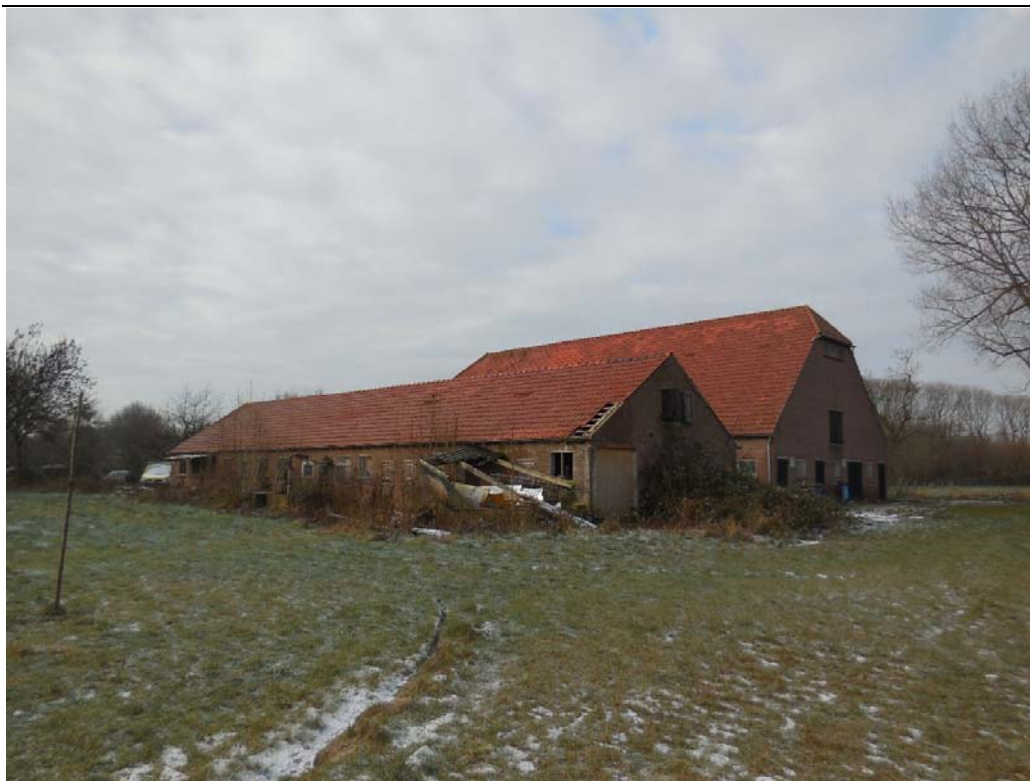
Figuur 2.3 De boerderijwoning op de achtergrond en de te slopen vrijstaande schuur op de voorgrond
