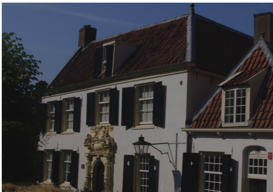
zolderkamer bovenwoning Bruntenhof 5 met één kleine dakkapel
