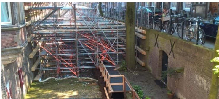
Stempelconstructie in de gracht nabij muur Universiteit
