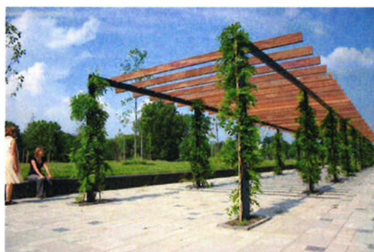
klassieke pergola-constructie met staanders en liggers als basis voor een loofgang en bladerdak
