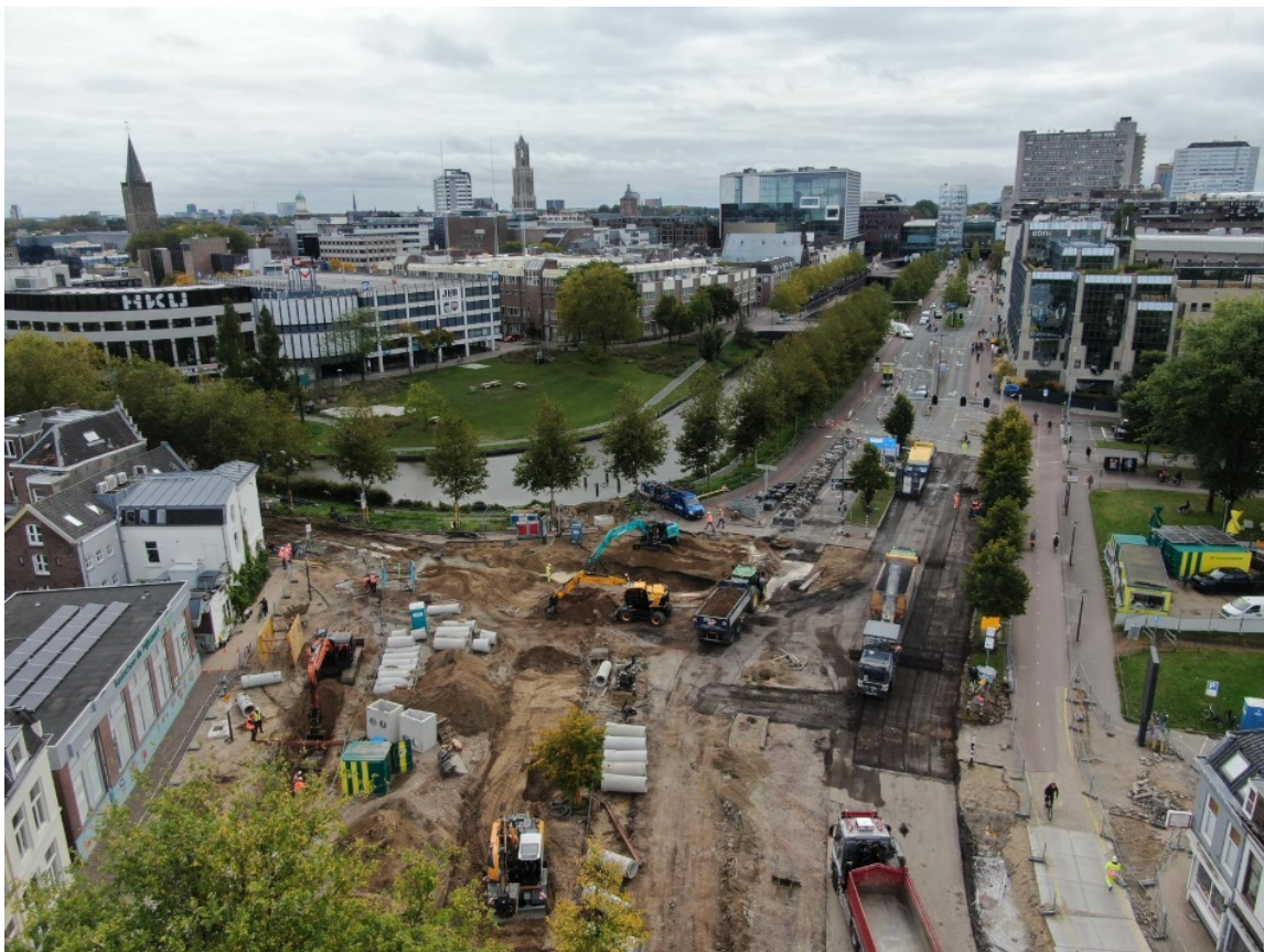
Luchtfoto werkzaamheden op kruising Amsterdamsestraatweg/Weerdsingel
