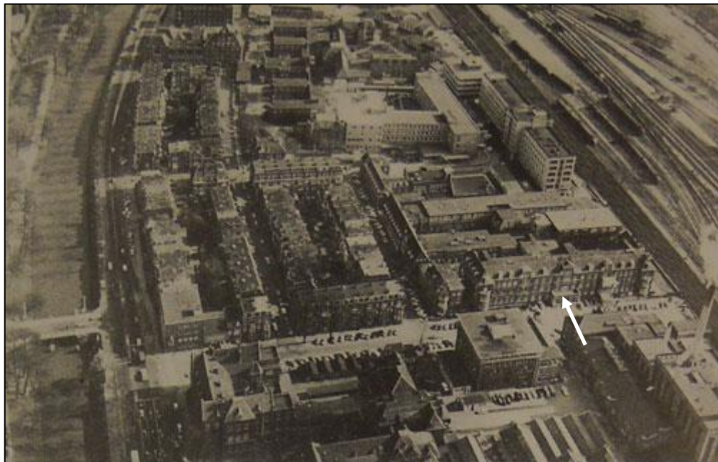
Afb. 3 Oblique luchtfoto van het SAZU. Bominslag op het huis van gebouw III ter hoogte van de pijl. Rechts op de foto is de oostrand van het spoorwegemplacement zichtbaar. 84
