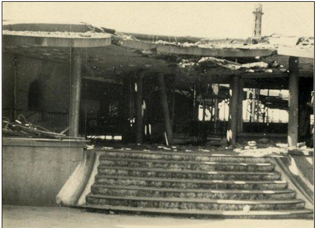
Afb. 2 Verwoest deel van het Centraal Station. 79
