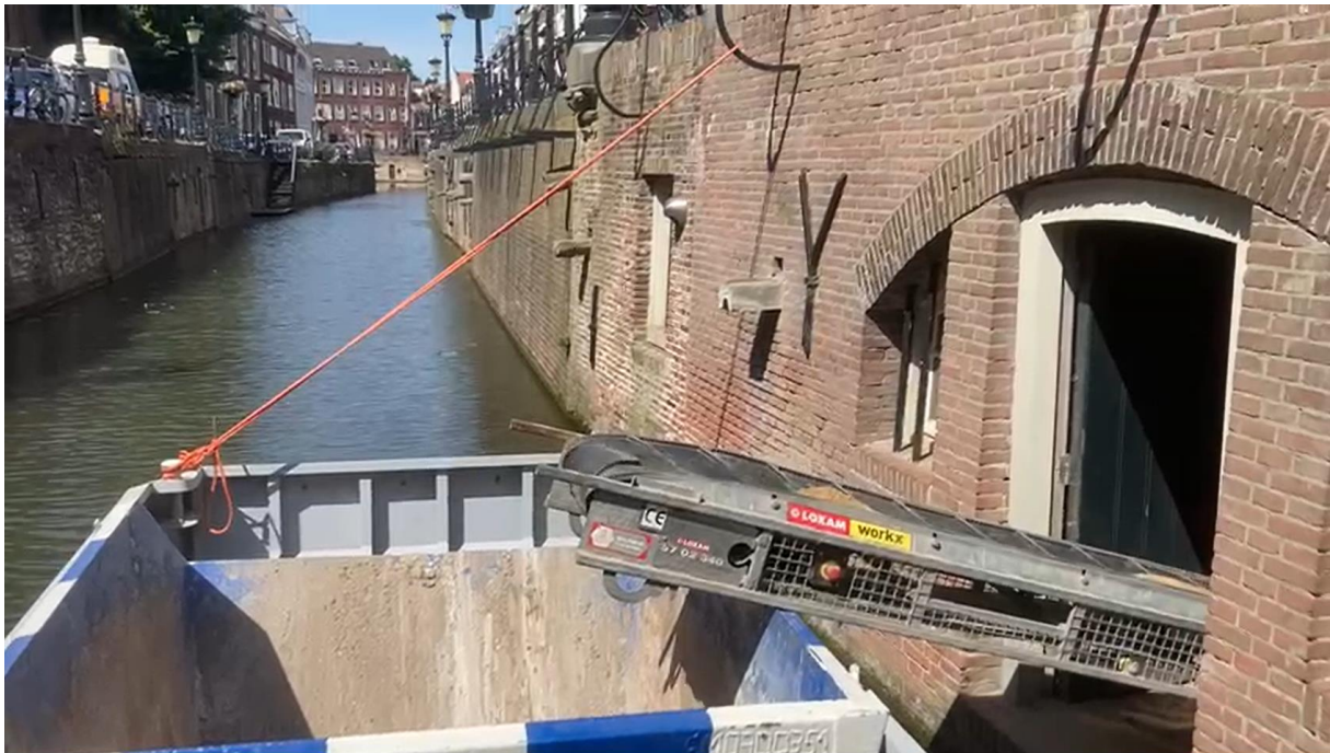
Overslag zand naar container op de Plompetoren Gracht 3
