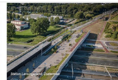
Combineren station en verbindingen
