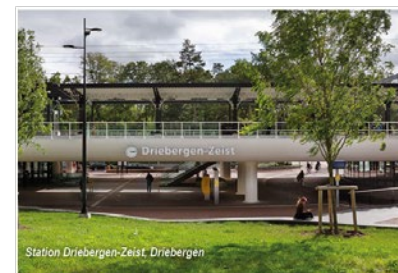
Doorlopend maaiveld onder station
