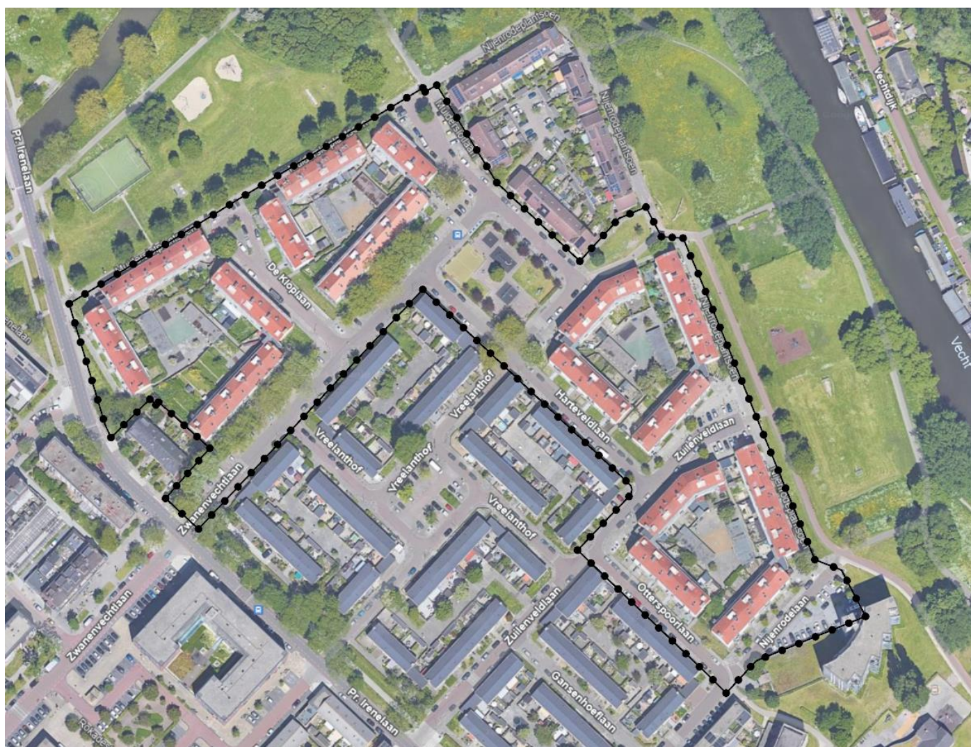
Luchtfoto van het buurtje met het plangebied (zwarte lijn). De opgave betreft de sloop en vervanging van de vier bouwblokken met rode daken.
